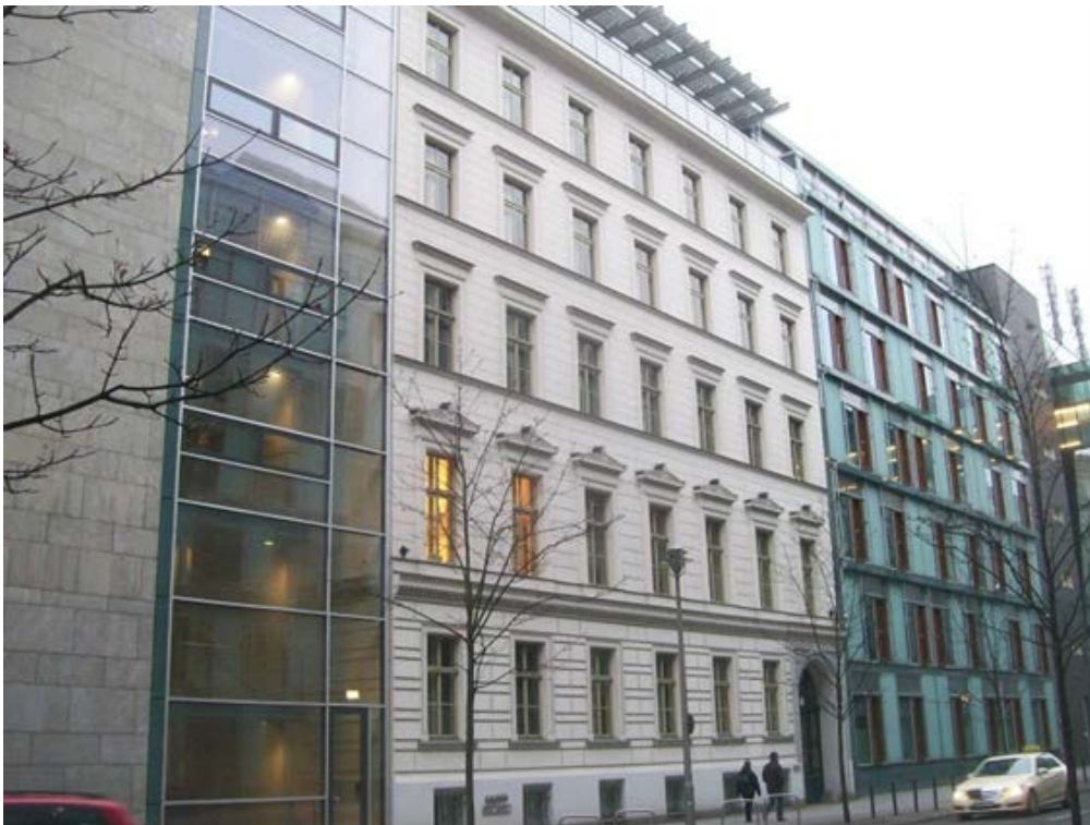
Abb. 8: Das Gebäude, in welchem die Chemische Gesellschaft die Geschäftsstelle unterhielt (Foto: Dr. Axel Schunk, 2013)
