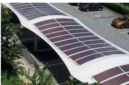
Abb. 6. Kommerziell erhältliche Dünnschichtsolarzellen, auf einem Parkplatzdach angebracht.
