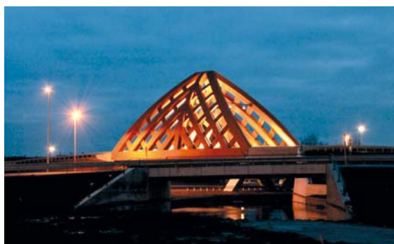
Abb. 9. Brücke aus acetyliertem Holz (Accoya-Holz)
