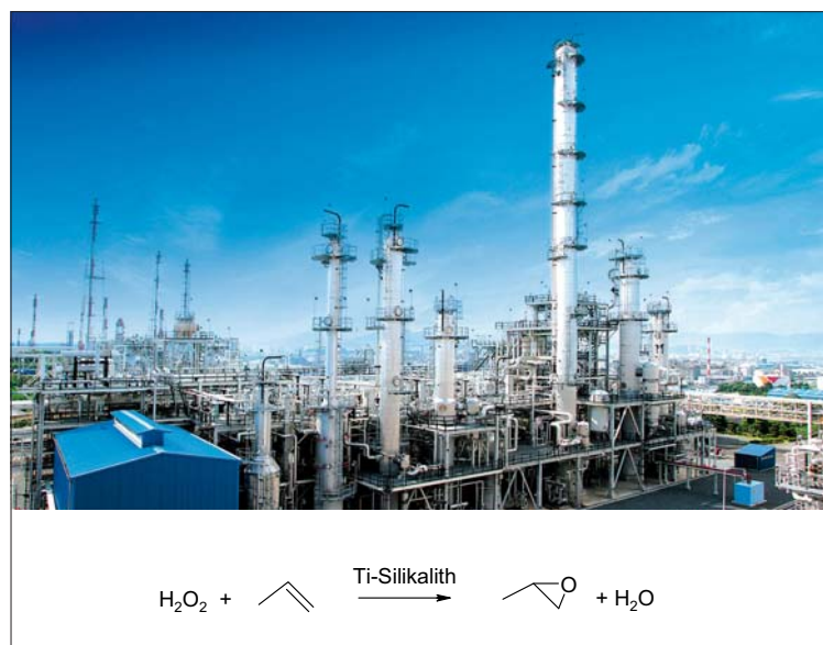
Abb. 3. Die südkoreanische SKC produziert in Lizenz von Evonik und Uhde in Ulsan Propenoxid nach dem HPPO-Verfahren. (Foto: Uhde)
