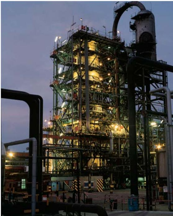
Abb. 2. Dreiphasenreaktor von Sasol in Südafrika zur Fischer-Tropsch-Synthese basierend auf der Slurry-Technik (Suspension aus Katalysator, flüssiger Produktphase und Synthesegas). (Foto: Emerson Process Management)
