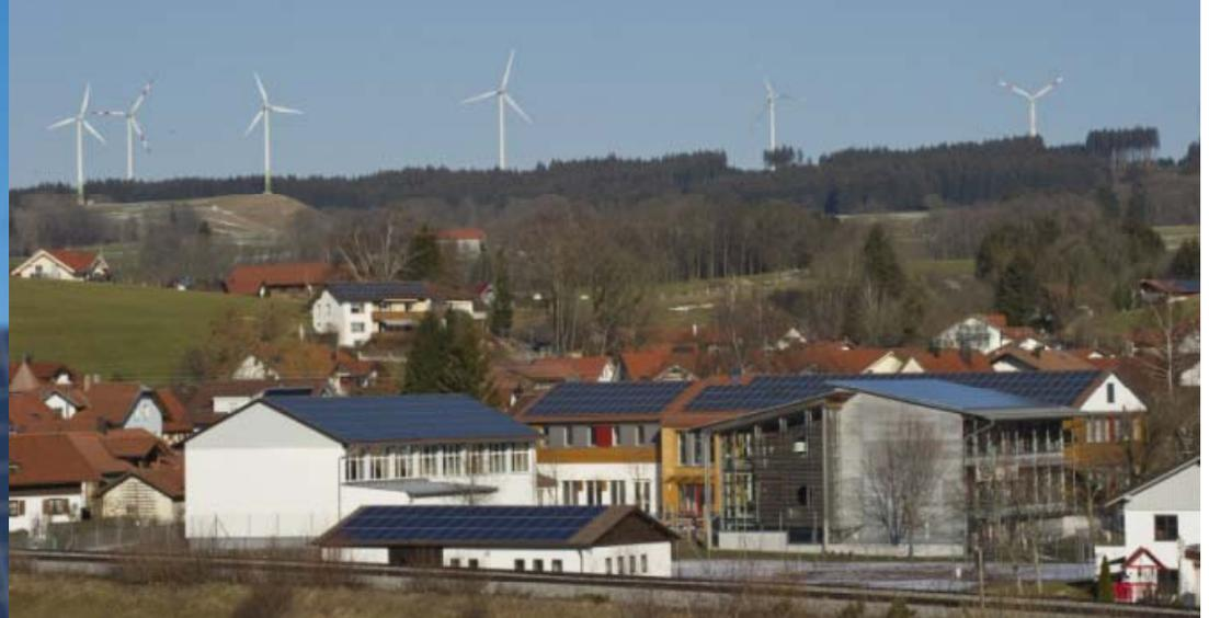
Dezentrale Energieversorgung, intelligente Stromnetze – Beispiel Wildpoldsried, Allgäu: Wind, Solar, Biomasse ... 3x mehr Stromerzeugung als Verbrauch, Schwankungen 8 MW / halbe Stunde. 200 Messstationen, regelbarer Ortsnetz-Trafo, Stromspeicher, Elektroautos, autonome Software-Agenten
