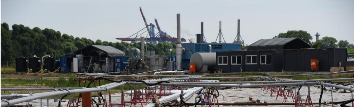
**Abb. 2:** Beispiel einer Sanierungsanlage für eine thermische In-situ Sanierung von Boden und Grundwasser
