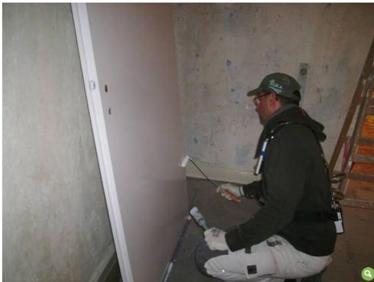
Abb. 2: personenbezogene Expositionsmessung bei Lackierarbeiten auf einer Baustelle
