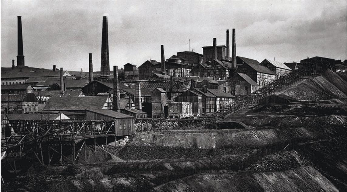
Abb. 9: Die Schwefelsäurefabrik wurde von der großen Bleikammeranlage dominiert. Hier fand aber auch die Anhydridproduktion nach dem Kontaktverfahren ihr Unterkommen. Die Aufnahme aus dem Jahr 1927 wurde freundlicherweise von Franz-Peter Kolmschlag (Freiberg) zur Verfügung gestellt.
