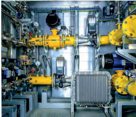
Das Spektrometer für die infrarotaktiven Bestandteile des Erdgases und der Wärmeleitfähigkeitssensor zur Wasserstoffmessung sind an einem Erdgas-Bypass des Fraunhofer ISE installiert. Das Messgerät befindet sich in einem explosionsgeschützten Koffergehäuse mit Kühlrippen (im Bild rechts unten). (Foto: H. Kock/ Fraunhofer IPM)
