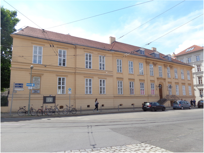
Abb. 8: Magnushaus Am Kupfergraben (Foto des Autors Juni 2017).
