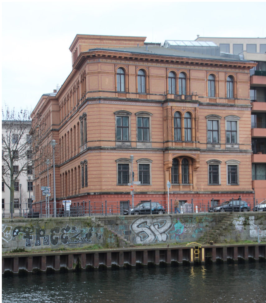
Abb. 6: Das seit 2001 leerstehende Gebäude des ehemaligen Institutes für Physikalische und Theoretische Chemie der Humboldt-Universität an der Ecke Bunsenstraße/Reichstagafer steht heute an der Stelle des früheren Wellingschen Hütten- und Scheidewerkes, Quelle: Fotografie Alexander Kraft, Januar 2020.
