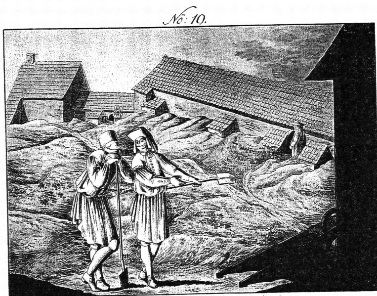
Abb. 4: Abscheidung von Arsenik in langen Rauchkanälen ( 28 , Bild 19)
